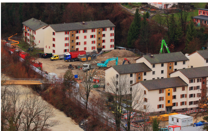
Ein Stück Geschichte verschwindet – die bisherige Siedlung wird abgebrochen.
