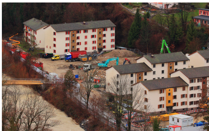
Un pezzo di storia sta scomparendo: l'insediamento precedente viene demolito.
